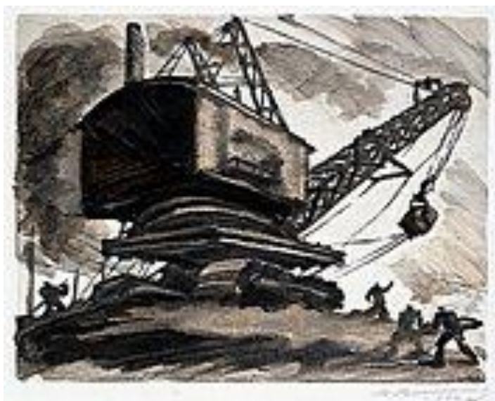
Ю. Великанов. Строительство электростанции на реке Свирь
